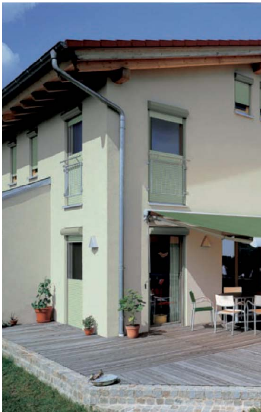
Außenliegender Sonnenschutz: Rollläden Bild: WAREMA
